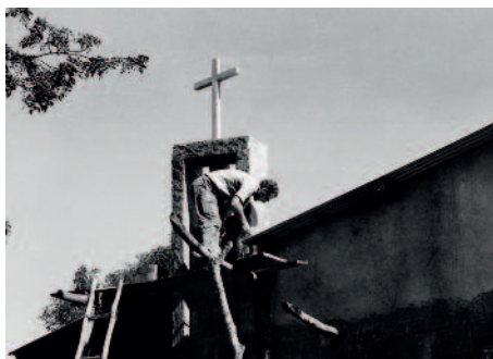
Bruder Marzellin Tschugmell bei Bauarbeiten auf dem Dach der Kirche von Cubal
